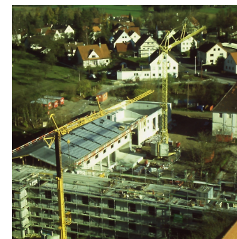
bâtiment neuf du centre de formation et du restaurant
