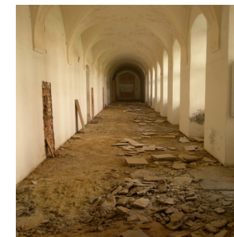
La rénovation complète des bâtiments historiques du monastère
