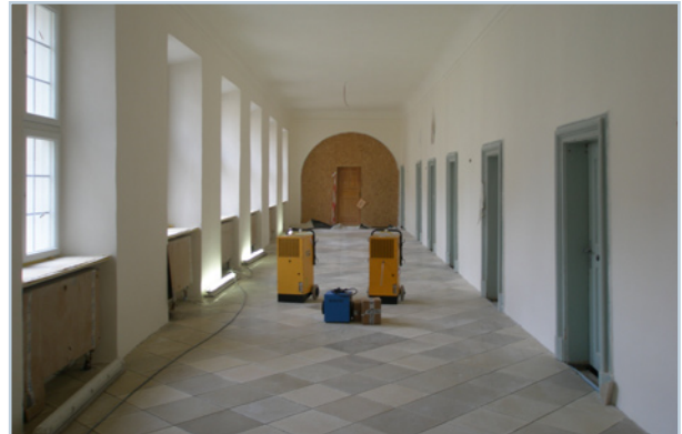
Entfeuchtung des renovierten Gebäudeteils.
