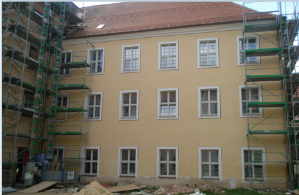
Fassadenarbeiten am Mittelbau im Innenhof des Klosters.
