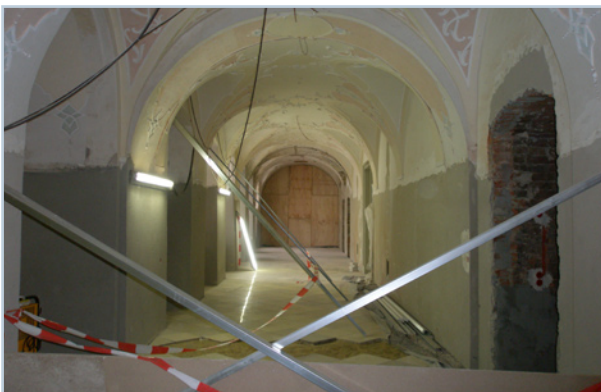
Neuerlegung der Bodenplatten.
