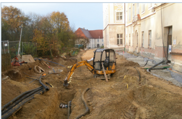
Bodenarbeiten vor dem Klostergebäude.
