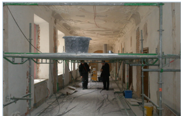
Ausbesserung der Stuckarbeiten.
