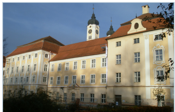
Teile der Außenfassade sind bereits fertiggestellt.
