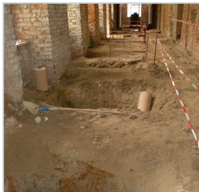
Kreuzgang im Südtrakt während der Renovierungsarbeiten
