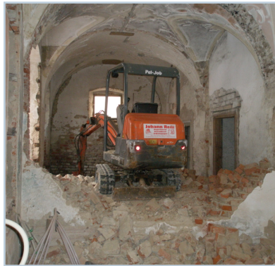
Gang im Erdgeschoss des Mitteltrakts zu Beginn der Renovierung
