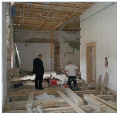
2. Obergeschoss im Mitteltrakt zu Beginn der Renovierung
