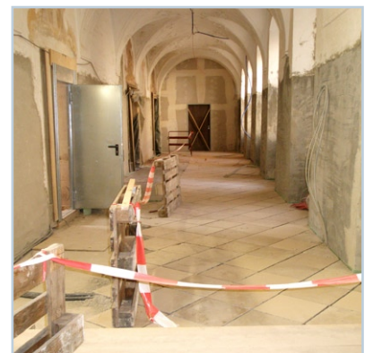
Im Erdgeschoss des Osttrakts werden bereits die Böden mit Solnhofener Kalksteinplatten neu verlegt.
