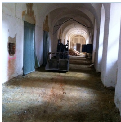
Im Erdgeschoss des Osttrakts werden bereits die Böden mit Solnhofener Kalksteinplatten neu verlegt.
