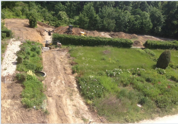
Der Klostergarten im Zustand während der Bauarbeiten.
