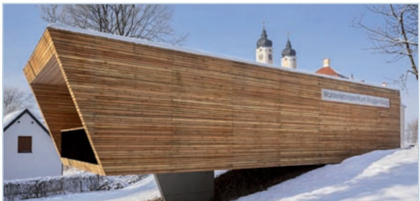
Blick von Osten auf den neuen Waldpavillon des WEZ Roggenburg.
