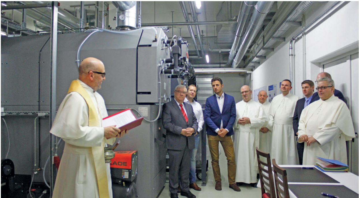
Im Jahr 2018 wurde die neue Energiezentrale im Keller des Klosterghasthofes eingeweiht.
