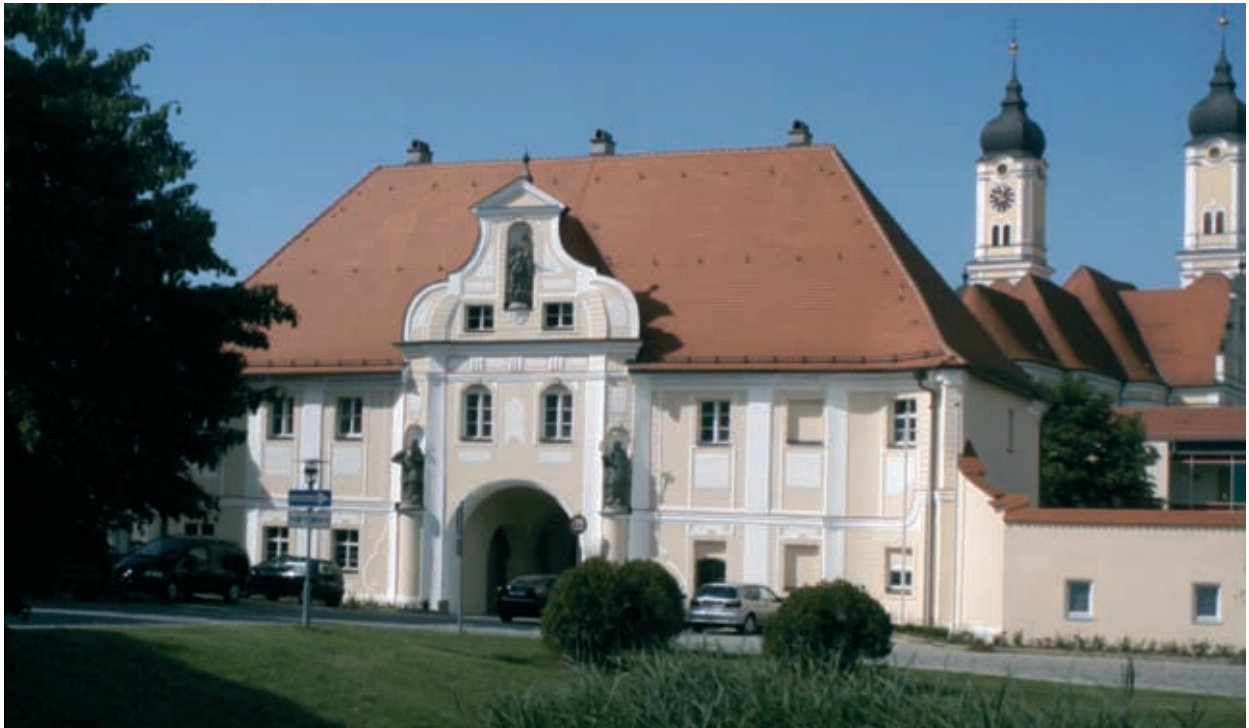
Vormals wie heute der Haupteingang zum Klostergelände: das obere Torgebäude.
